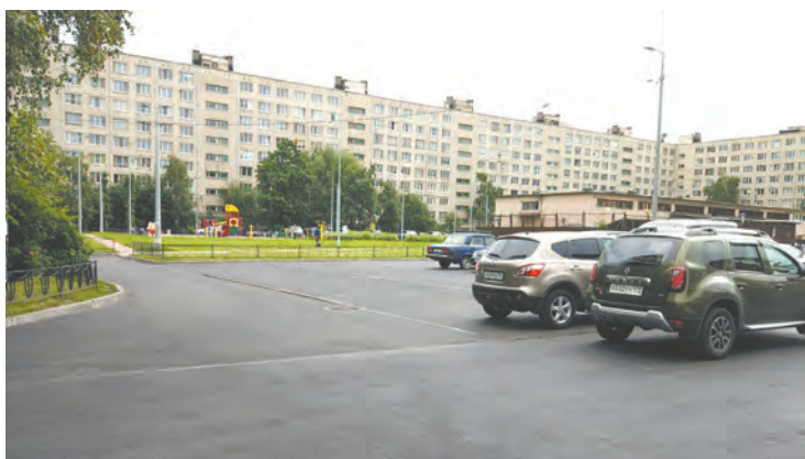
Ремонт асфальтового покрытия по адресу: улица Ярослава Гашека, д. 4, к. 1
